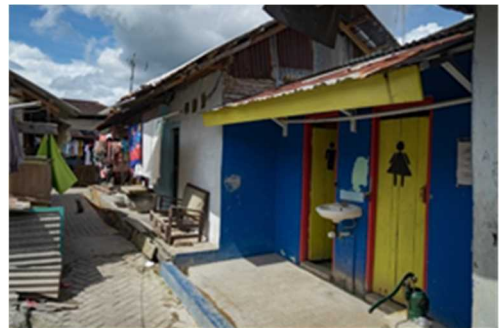
プロジェクト実施後のトイレの様子
