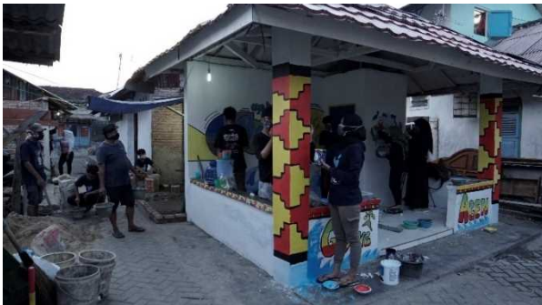
施設の修復と塗装の様子
