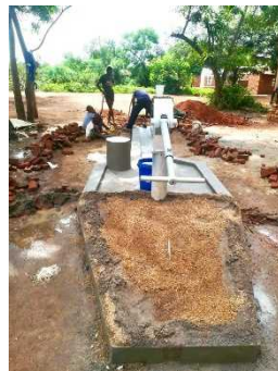
手押しポンプ 水受け設置工
