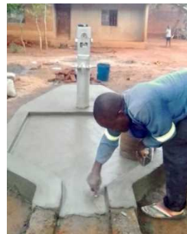
水受け外枠工
