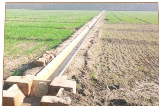
用水路へのパネル施工状況
