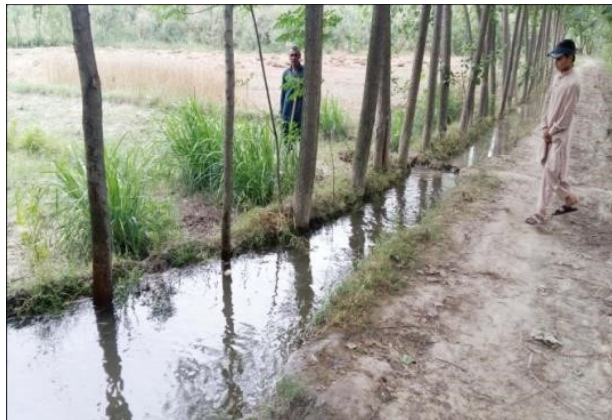
土留めのない用水路
