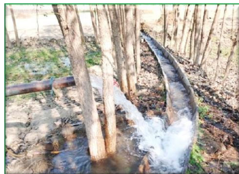
かんがい用水路への給水
