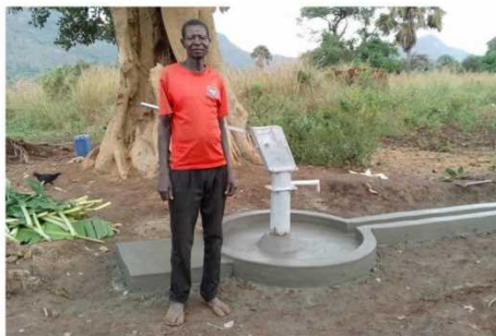
打ち抜き井戸補修完了
