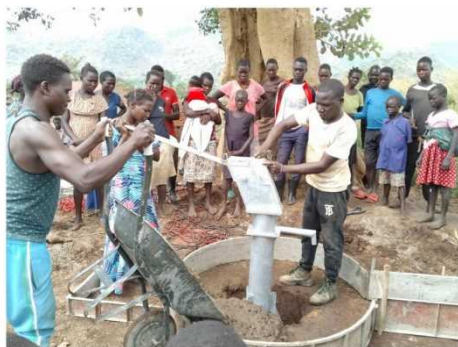
水受け補修と手押しポンプ設置
