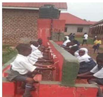
専用水中ポンプが稼働した手洗い場
