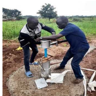
手押しポンプ設置工
