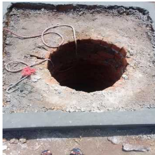
浅井戸レンガ擁壁工
