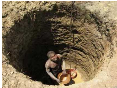
浅井戸手掘り掘削工
