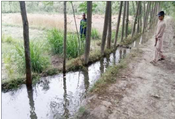
土留めのない用水路
