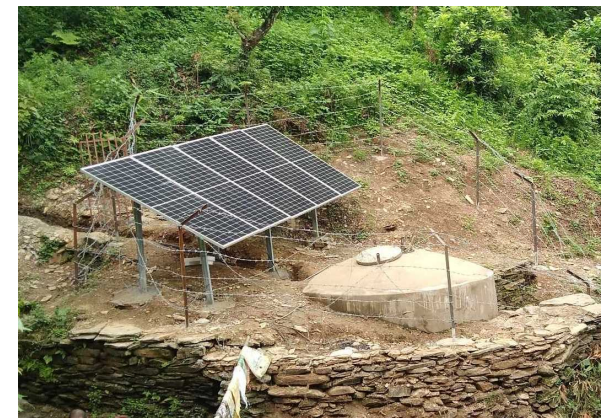
ダルビッシュ有 水基金 第16号 (貯水槽補修、ポンプ送水のための太陽電池パネル設置状況)
